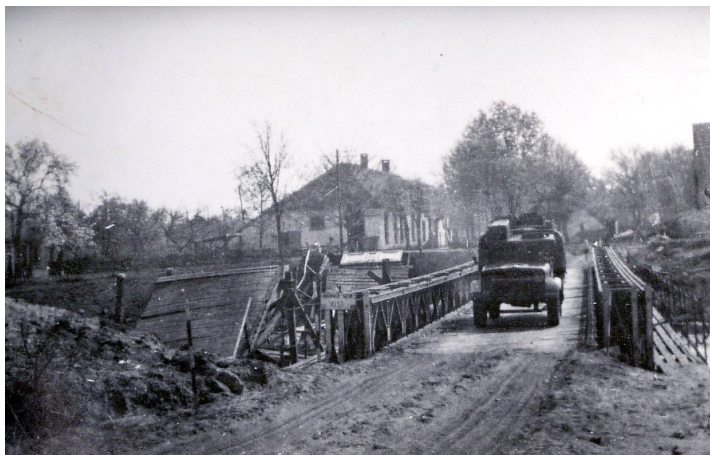
De brug over de Regge bij Nieuwebrug was opgeblazen. Hier wordt gebruik gemaakt van een zogeheten baileybrug
